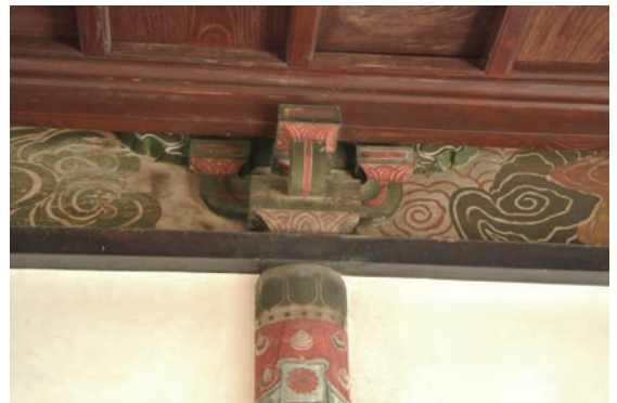
図25 内部組物 向拝側柱筋
