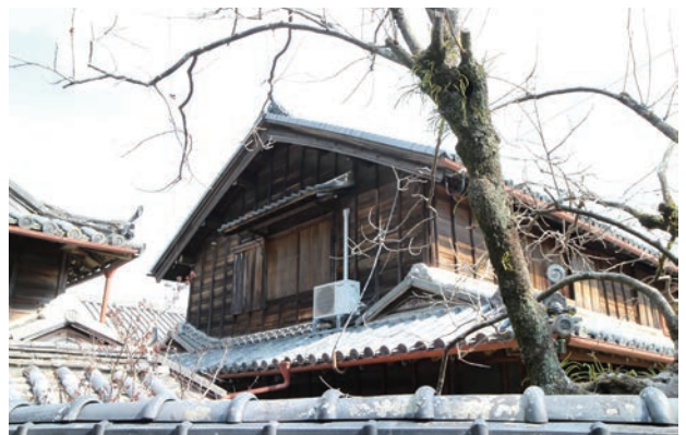
図40 【榊町－N家住宅】比翼入母屋破風
