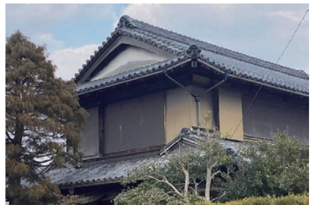
図35 【立江町-K家住宅】比翼入母屋破風
