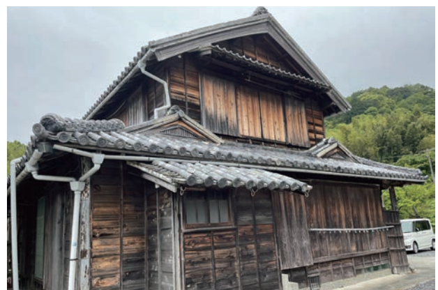
図30 【田浦町－Y家住宅】比翼入母屋破風
