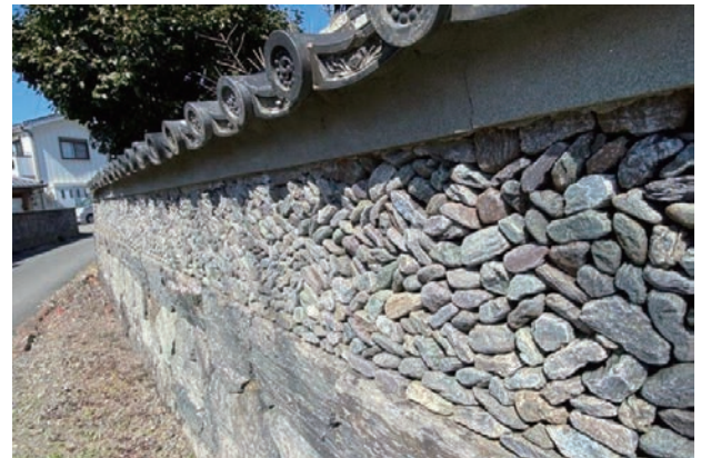
図34 【立江町-K家住宅】大神子石を用いた築地塀
