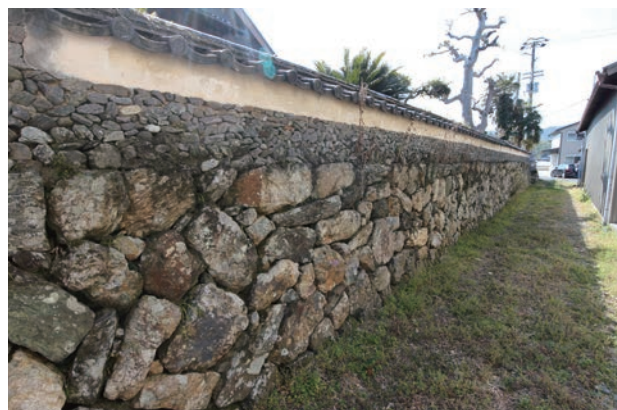
図20 大神子石（緑泥片岩）を用いた築地塀
