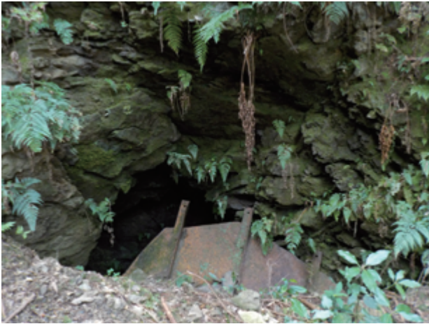
図5 西川谷の本坑。中央下が開口部を塞いだ鉄板
