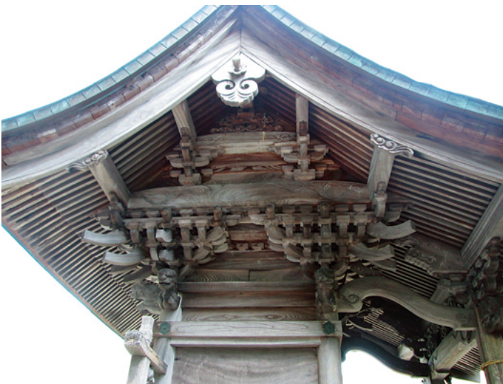
蛭子神社本殿（永井町）の四方八方に出る組物
