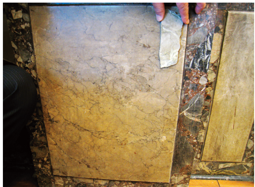
写真11 新井ビル(中央区今橋, 旧報徳銀行大阪支店, 1922(大正11)年建築)1階壁面の「加茂更紗」とその上に重ねた石材見本(右). 建物は国の有形登録文化財.
