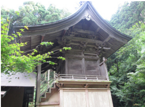
図2 三間社の八幡神社本殿（加茂）
