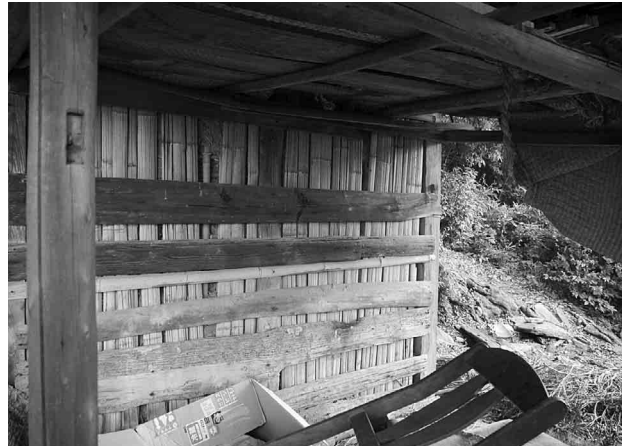
図18 ヒシャギ竹の外壁
