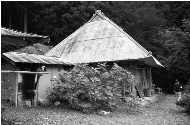
図16 葺き降ろし屋根
