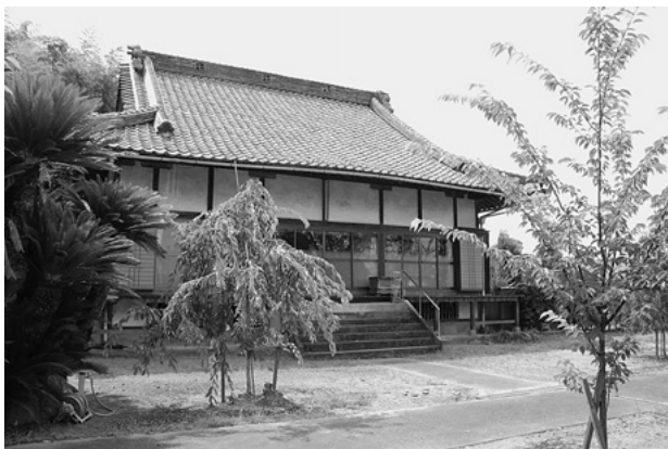
図3 西法寺 本堂 東麓
