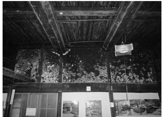
図13 コキ柱・オトシコミの構法
