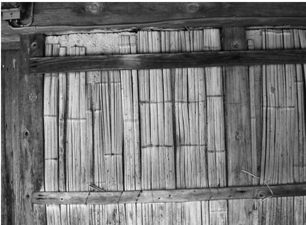
図7 真壁でひしやぎ竹押さえ
