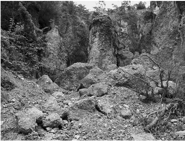
図4 2004年台風16号による土柱の崩落直下の状況 (2004年9月22日)
