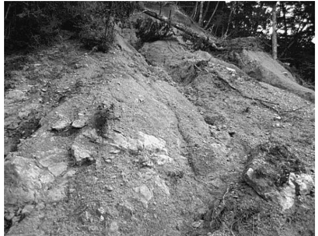
図8 坂本断層破碎帯に沿う林道法面の崩壊。富士ノ池谷上流, 林道標高1,240m付近の山側斜面, Loc. 9
