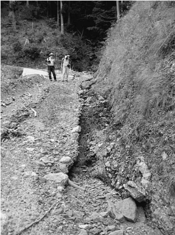
図6 降雨時の出水による屋根又谷断層破碎帯上の林道の侵食, Loc. 4
