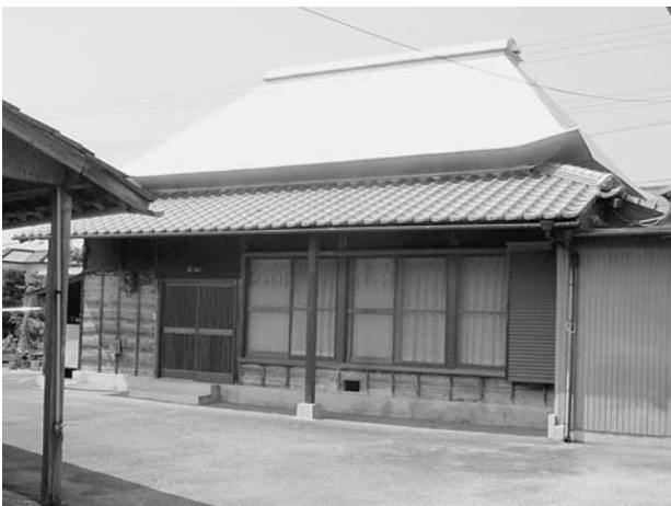
図28 A家主屋外観
