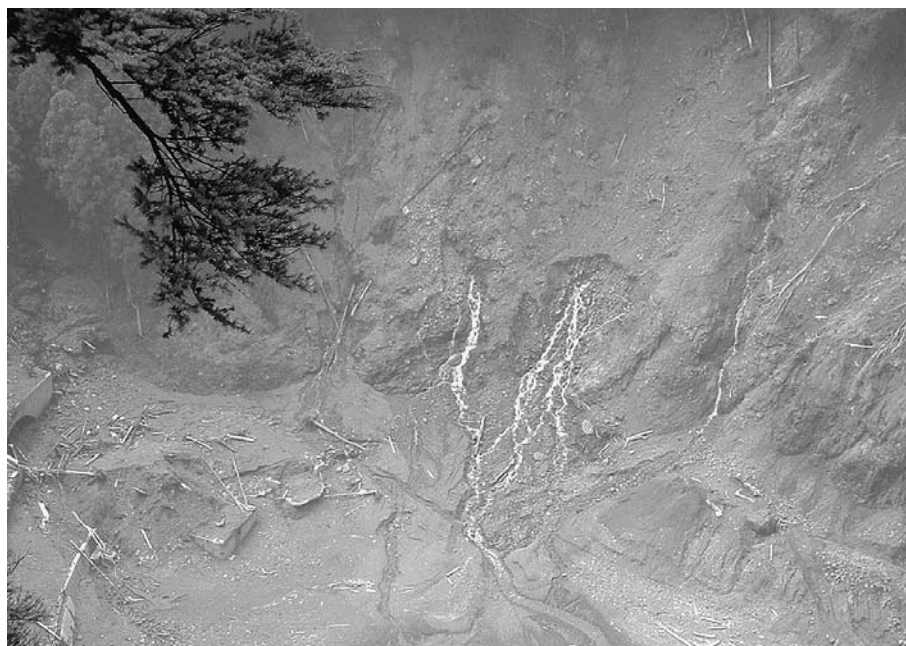
写真2 阿津江地区の斜面崩壊の土砂により埋没した符殿トンネル坑口（井内海俊撮影）
