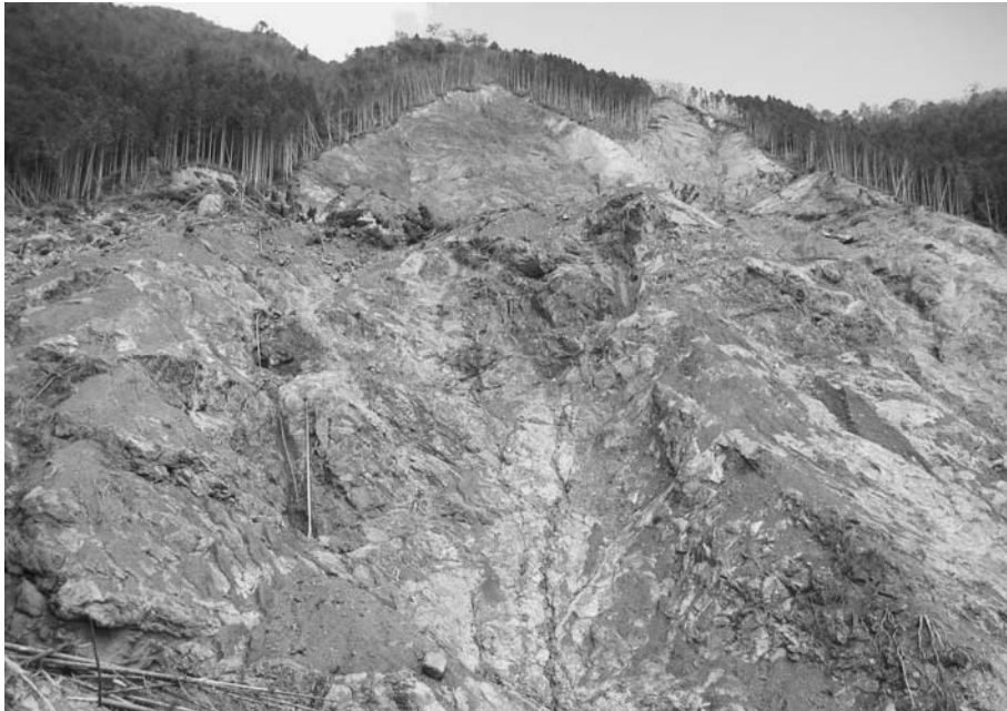
写真4 大用知地区の斜面崩壊の全景 (石田啓祐撮影)
