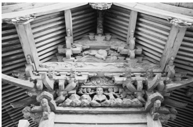
図4 八方向に延びる組物 八幡神社（掛盤）
