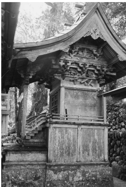
図1 八幡神社（坂州）本殿
