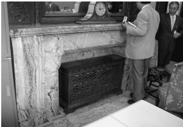
図7 「木頭石」を使った国会議事堂参議院副議長室応接室暖炉
