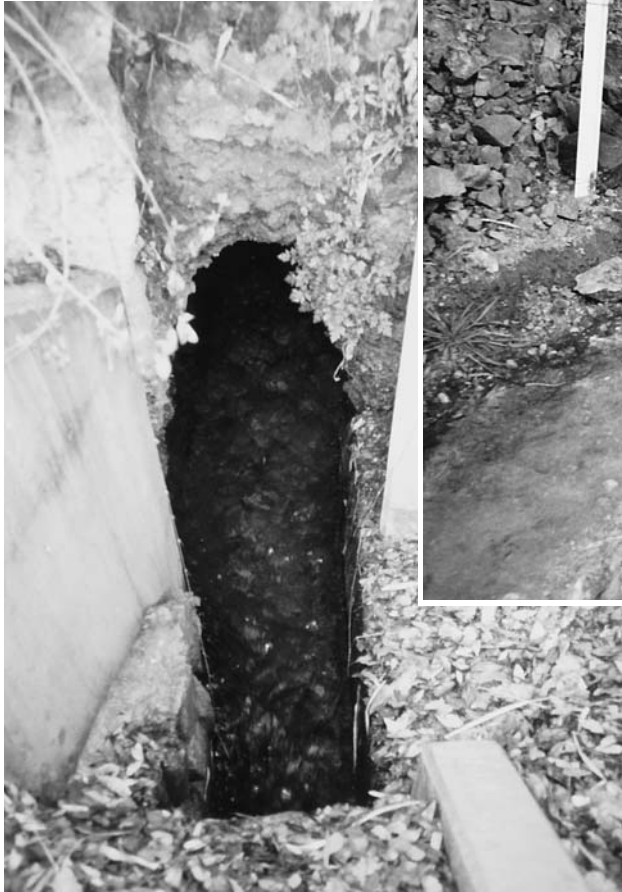
三村用水（トンネル吐水口）
