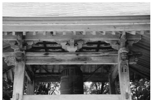
図23 鐘楼 柱頭部組物
