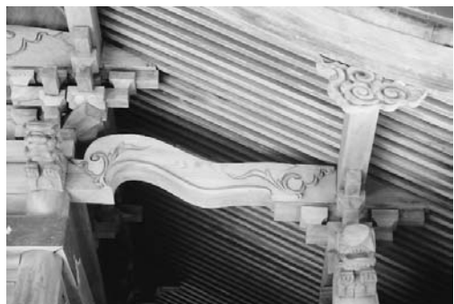
図11 本殿繫海老虹梁
