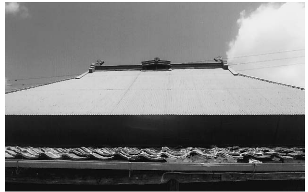
図37 屋根部分の通気口
