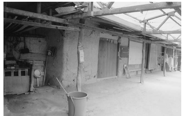
図38 主屋正面の差し掛け
