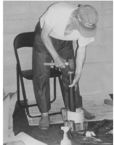
写真2 筒込みの作業
