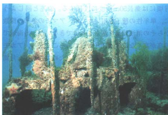
写真3 ガラモ付着用ブロック
