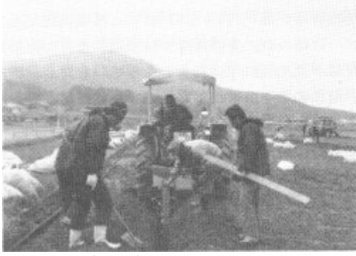
転作研修 昭和58年1月19日 暗渠排水用パイプ・もみがらの埋設作業実習(石井)
