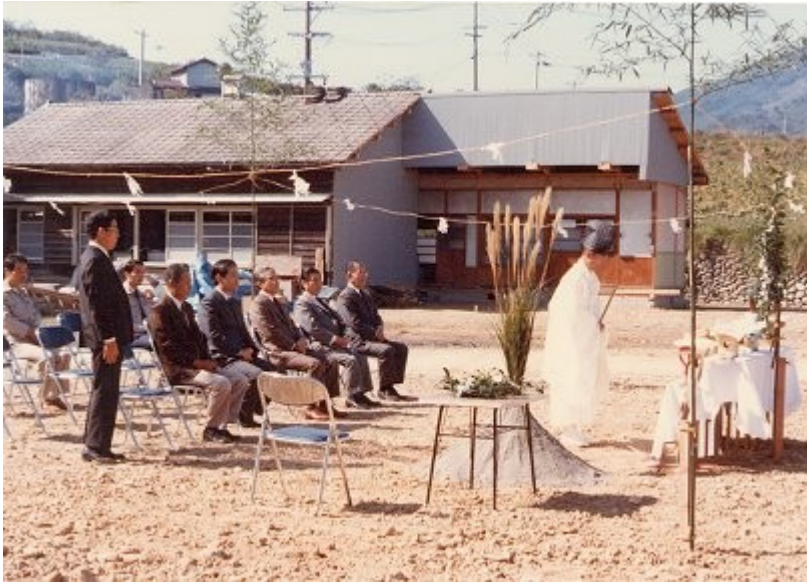
池田分場改築地鎮祭（昭和 57 年 10 月 27 日）
