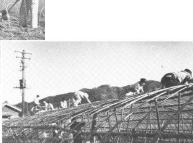
農試における竹製大型ハウス第1号の建設 (昭和34年)
