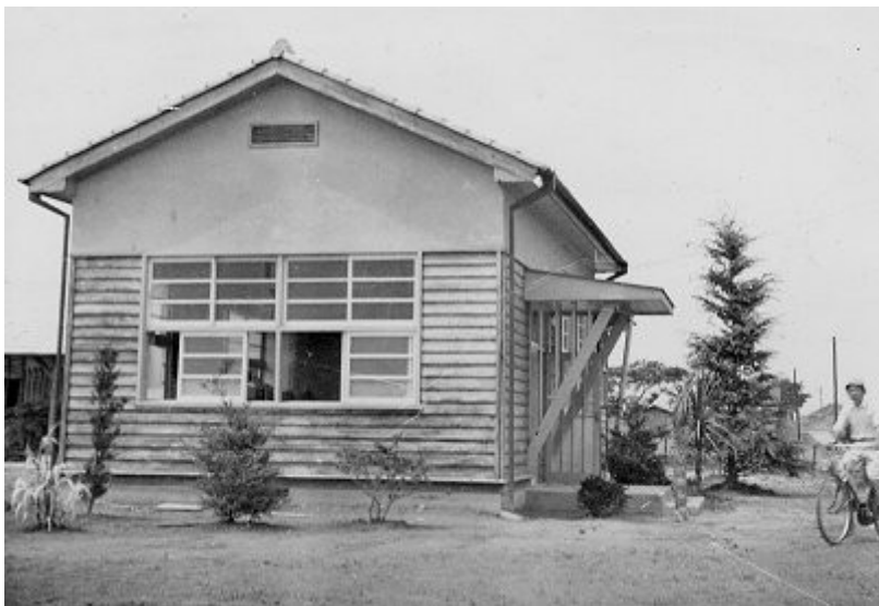
東側からみた藍住分場本館(同年)
