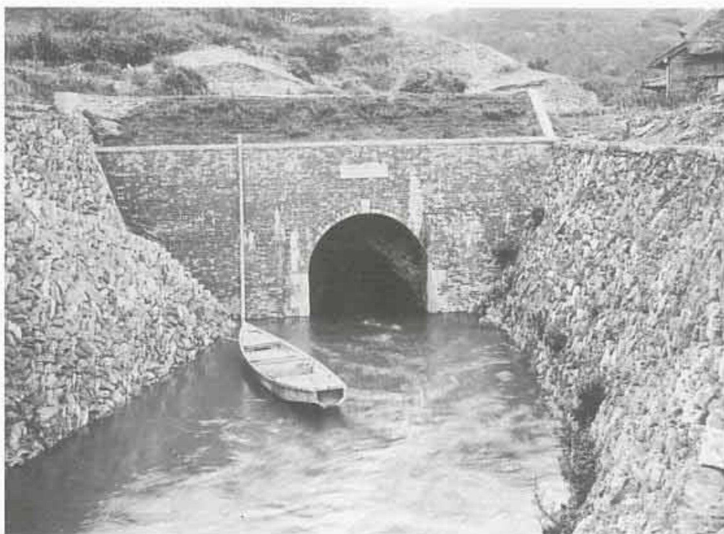
旧取水トンネル吐出口
