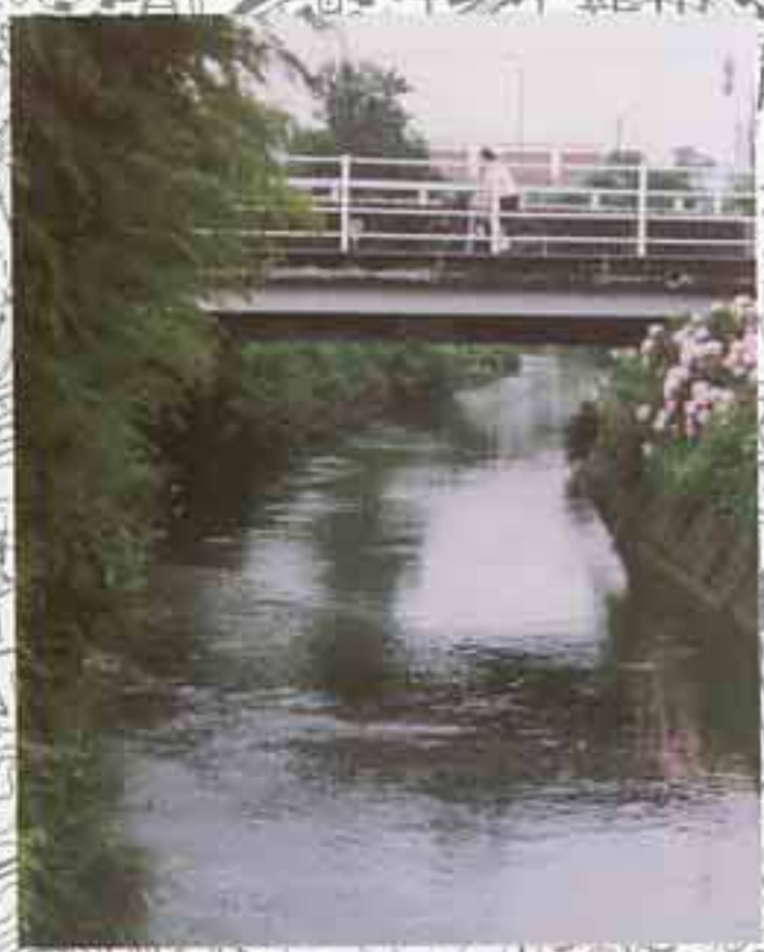
導水幹線水路
