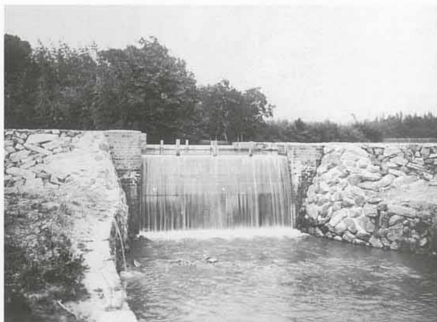
南部線三谷交叉樋
