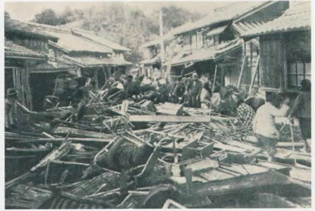
【写真3】浅川及び牟岐の被害写真 2
