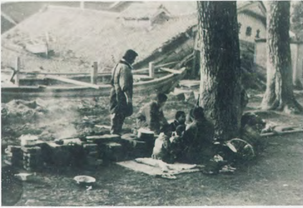
【写真2】浅川及び牟岐の被害写真 1
