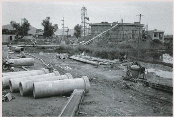
徳島市浄水場工事
