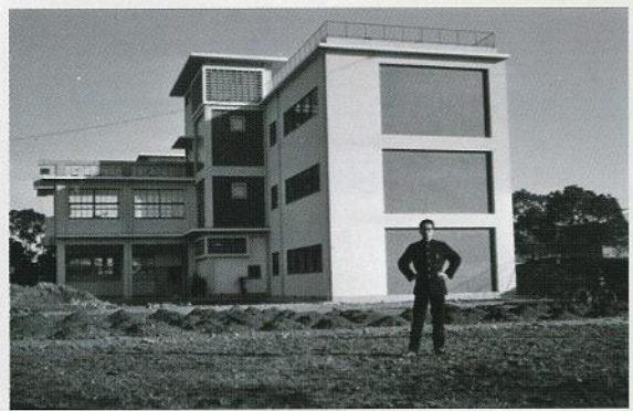
城東高校旧校舎建築工事現場にて
