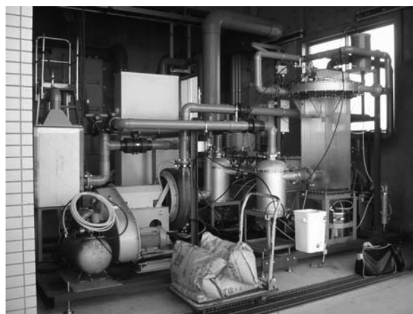
図2. 新方式脱臭装置のパイロット機
