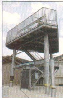
津波避難タワー
