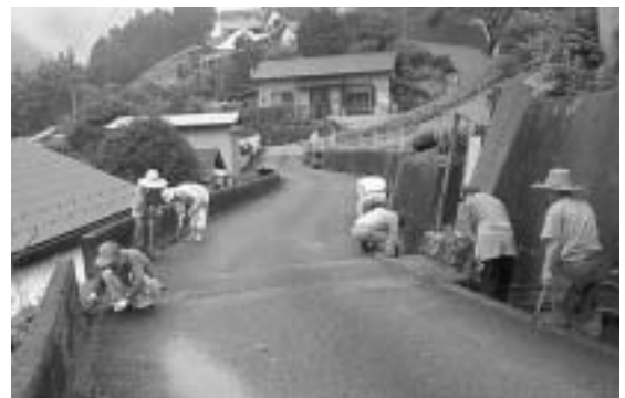
▲赤松集落 農道・水路の整備
