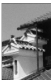
二層のうだつ （厨子・上下切妻）
