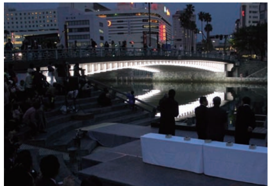
▲新町橋に整備された「光のマトリックス-白色LEDによるオペレッタ」の点灯式の様子=4月
