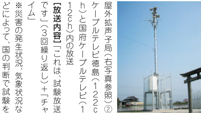
屋外拡声子局(右写真参照)②ケーブルテレビ徳島(122ch)と国府ケーブルテレビ(126ch)内の放送
