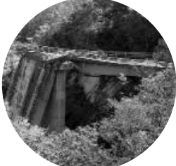
栗駒 復興のモニュメントとして残された祭時大橋
