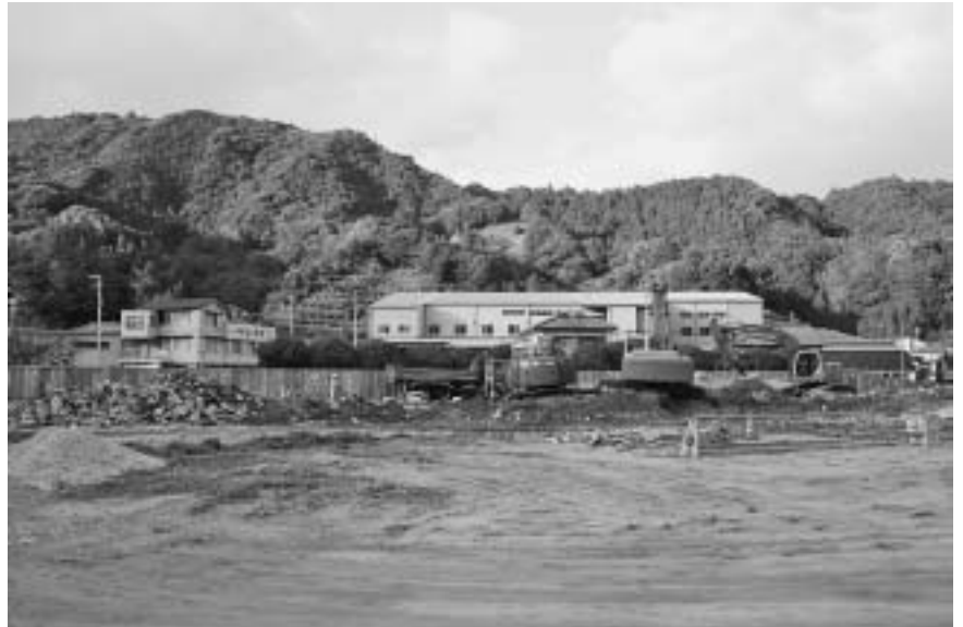
プール 更衣室と小プールの解体をおこないました。
