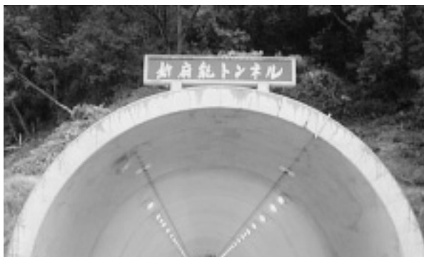
新府能トンネル銘板は、山根先生作
