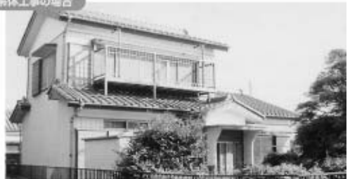
解体工事の場合
