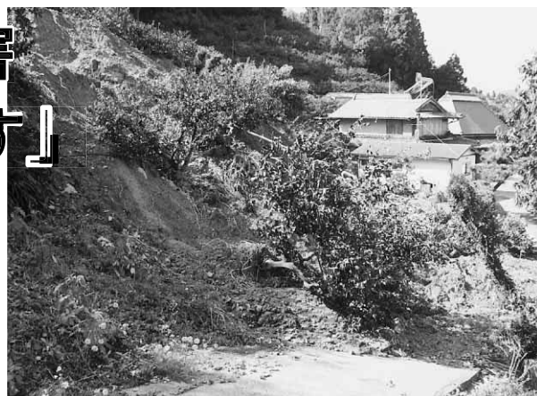
台風23号による村道東山線の被害
