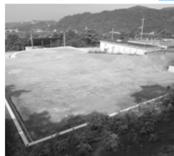
平草配水池築造事業の状況(造成工事完了)
