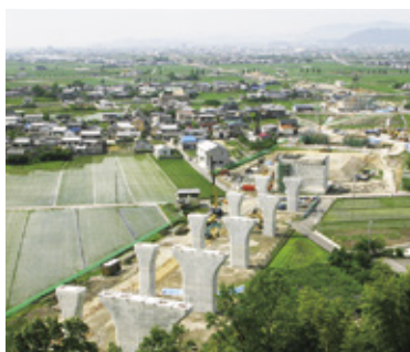
道路ができる前の橋脚(平成21年6月)
