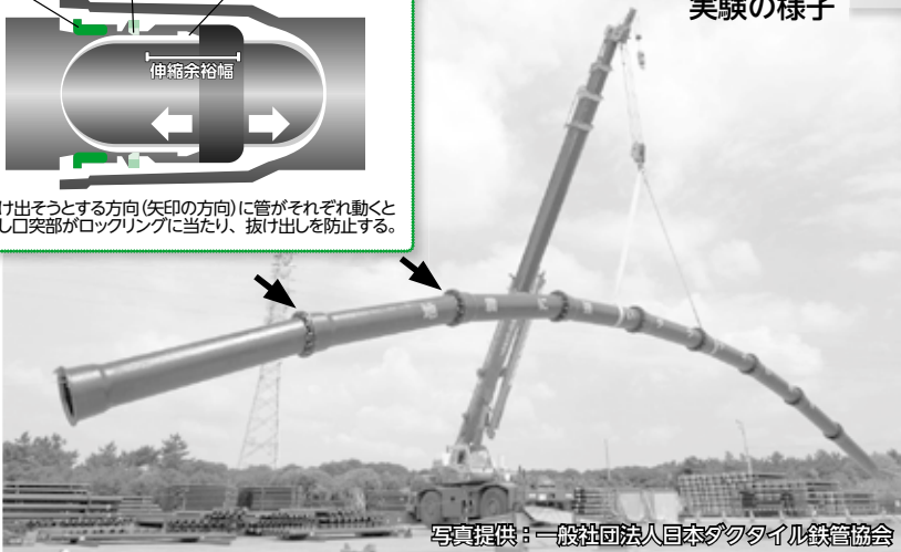
耐震管の吊り上げ 実験の様子
