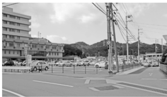
■ 道幅が約1.5倍広がり、対向が可能になった病院東側市道
