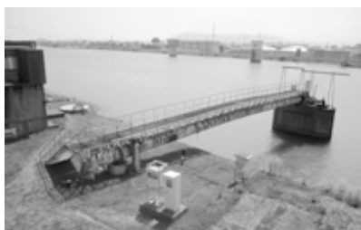
1 取水塔 旧吉野川の水をポンプで取り入れます。
