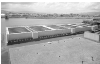
2 沈でん池 凝集剤を入れて水のにごりを固まりにして沈めます。
