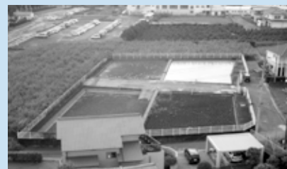
B 天日乾燥床 川から取り入れた水に含まれるにごりを集めて乾燥させます。
