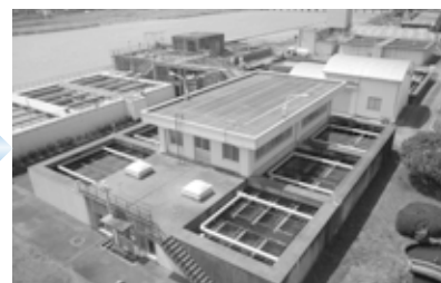
3 ろ過池 さらにきれいにするため、砂や砂利の層を通して小さなよごれを取り除きます。
