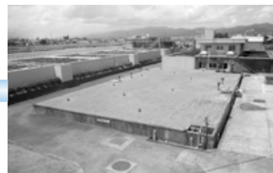
4 浄水池 きれいになった水を貯めておきます。
