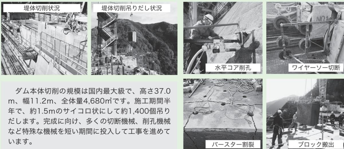
ダム本体切削の規模は国内最大級で、高さ37.0m、幅11.2m、全体量4,680m<sup>3</sup>です。施工期間半年で、約1.5mのサイコロ状にして約1,400個吊りだします。完成に向け、多くの切断機械、削孔機械など特殊な機械を短い期間に投入して工事を進めています。
