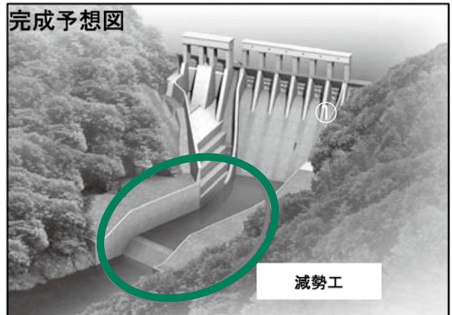
※当ダムのCSGはダム堆砂除去で発生する土砂を用いています。
