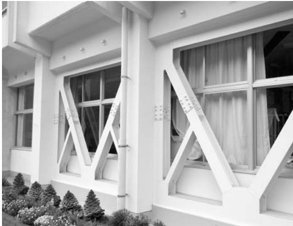
桜谷小学校 鉄骨ブレースにより補強
