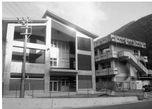
完成した新校舎(左)と旧木頭小学校校舎(右)
