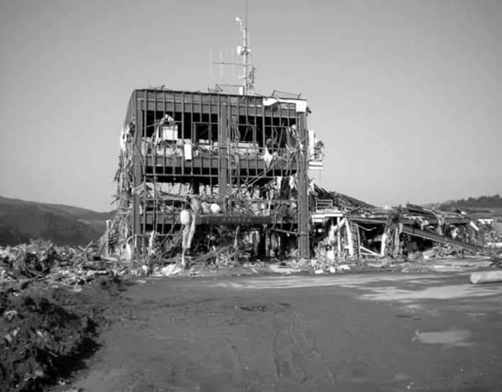
骨組みだけになった防災対策庁舎
