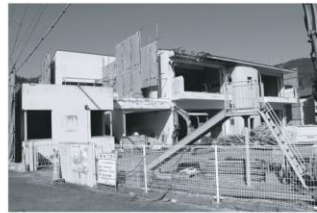
解体中の旧東部保育所
