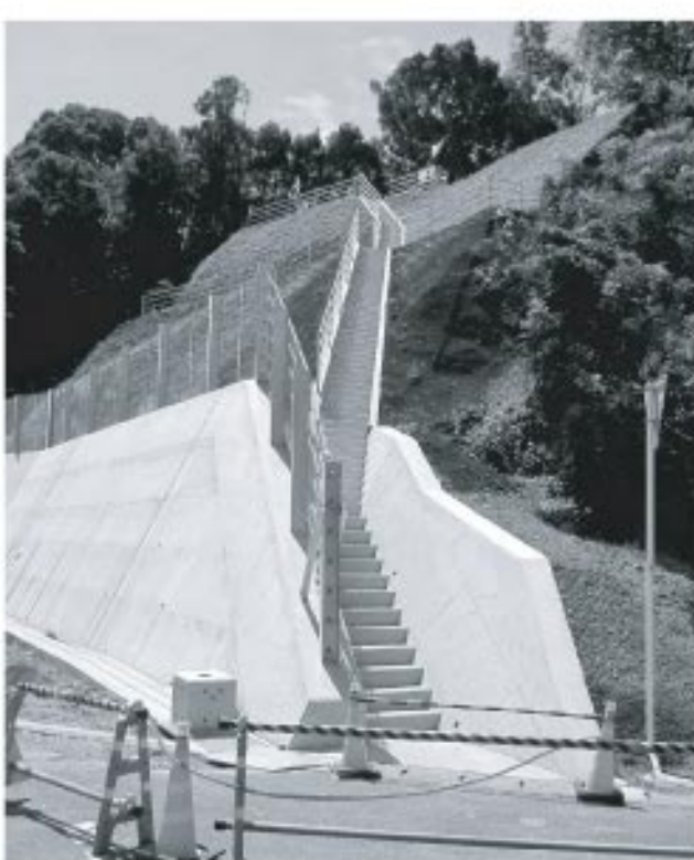
県道日和佐牟岐線自歩道工事
