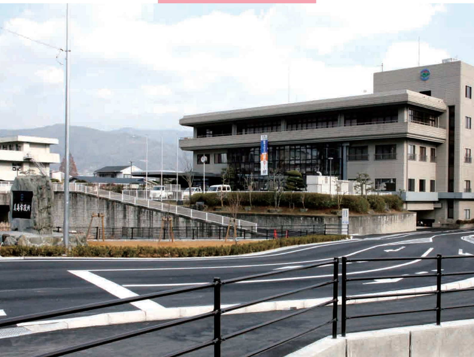
新しい庁舎進入路完成
