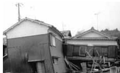
▲地震により倒壊した家屋
